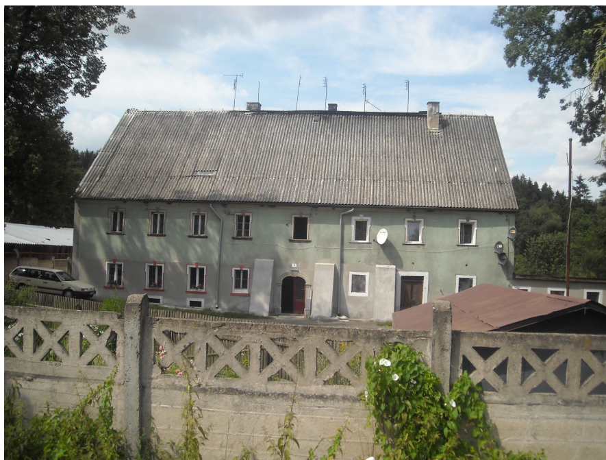
Fot. 5. Budynek mieszkalny pokryty płytami cementowo-azbestowymi – Nowa Ziemia 2.
