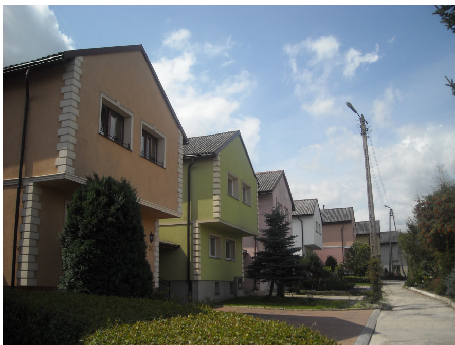
Fot. 3. Budynki mieszkalne pokryte płytami azbestowo-cementowymi (Jerzmanice - Zdrój).
