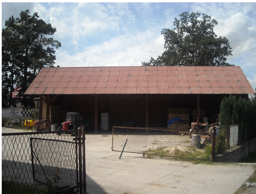
Fot. 2. Budynek gospodarczy pokryty malowanymi płytami azbestowo-cementowymi Wilków 47.
