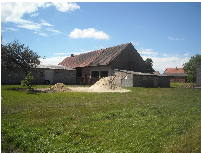
Fot. 4 Dachy, w tym zadaszenia azbestowe, o różnych spadkach. Budynek mieszkalny 45° i sąsiednie budynki gospodarcze 15°.
